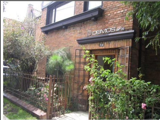
Foto 1. Fachada del predio ocupado por la empresa.
